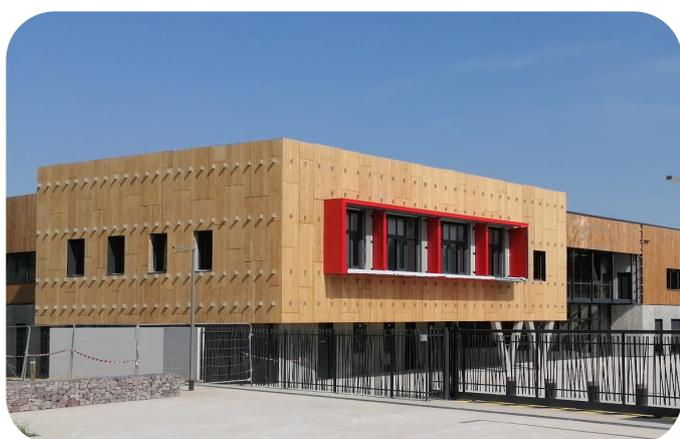
Nouveau collège « durable » de Laillé (2020) construit en charpente et bardage bois, avec l'installation de panneaux photovoltaïques. De potentielles extensions sont prises en compte dès la phase conception et la biodiversité avoisinante est protégée, même lors du chantier.
